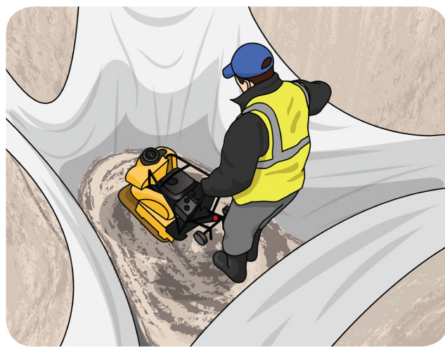
Рисунок: Выравнивание песчаного основания с геотекстилем
