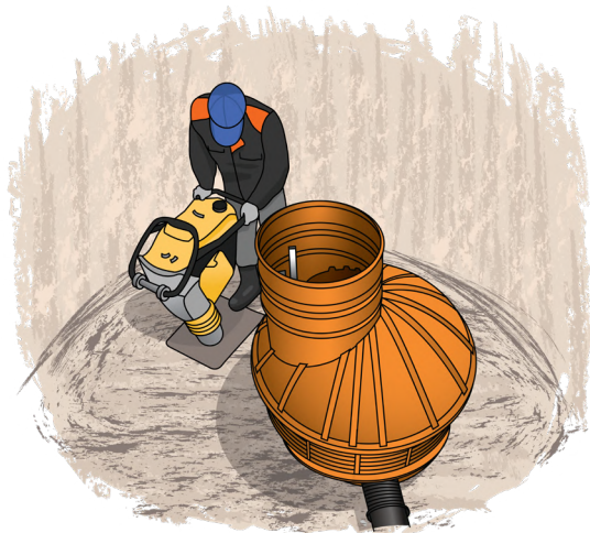
Рисунок: Послойная трамбовка
