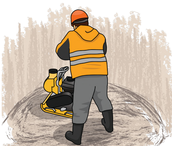
Рисунок: Выравнивание песчаного основания
